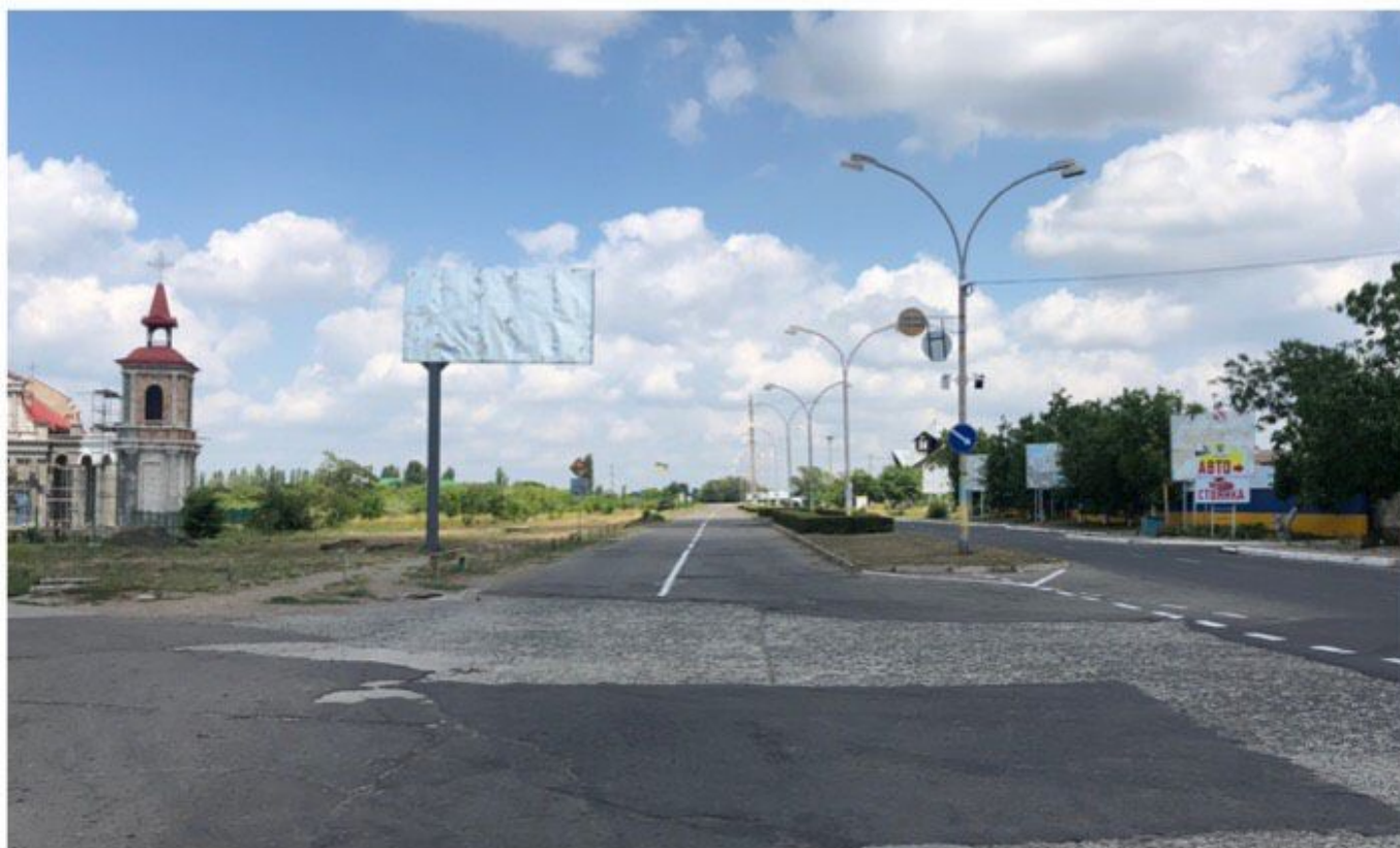
Сторона Б ( в сторону автодороги Н24)
